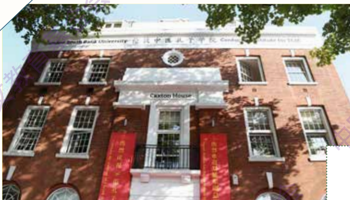
示范孔子学院大楼 Edifício do Instituto Confúcio Modelo
