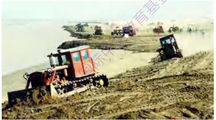
20世纪90年代初，在胜利油田清水沟流路入海段北侧浅海发现了储量巨大的新滩油田，但该地处于潮间带，开发艰难。工程技术人员于是萌生了把黄河引向东北方向、利用黄河泥沙填海造陆的设想。1996年，造陆采油工程实施，开挖引河，将黄河入海口门向东北偏转，这既缩短了河道，改善了防洪形势，又为造陆采油创造了条件。如今，一块数十平方千米的陆地露出海面，一口口油井也随之竖立在这块新淤的土地上，胜利油田由此成为中国第二大油田。
